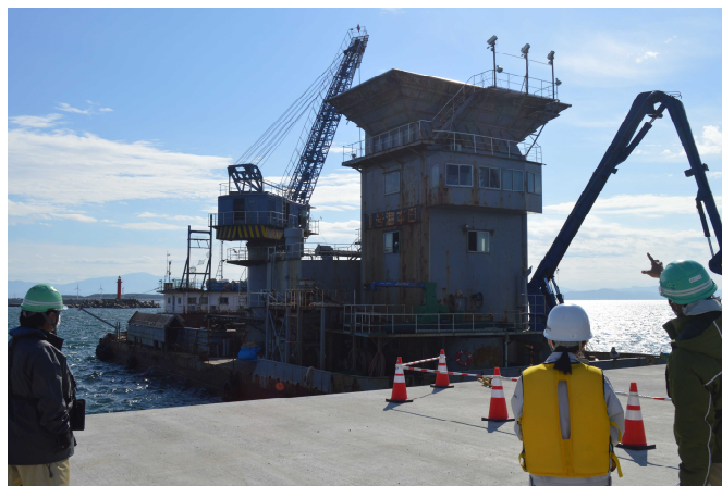
コンクリートミキサー船について 質問をする様子
