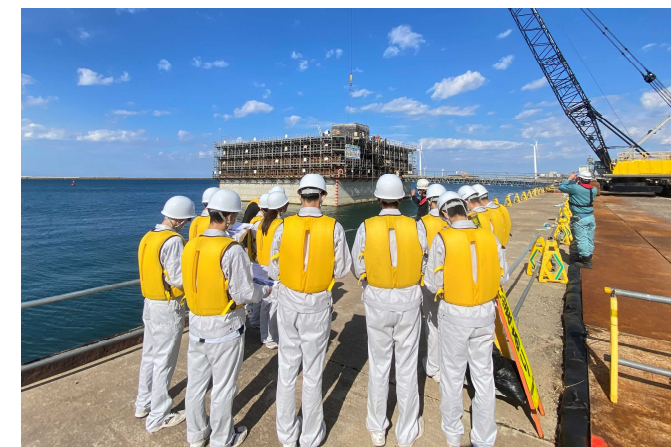
ケーソン製作現場で説明を受ける様子
