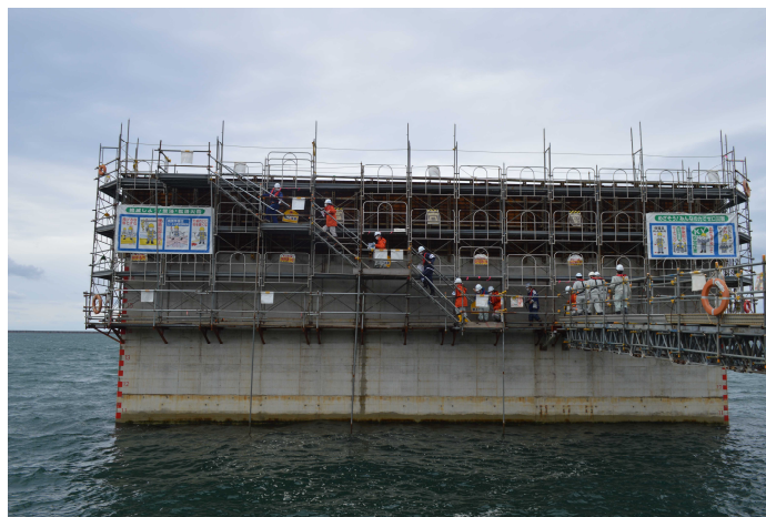
打ち継ぎ場(海上)で製作中のケーソン
