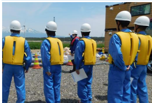
基地港湾整備現場の見学
