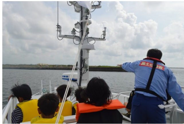
基地港湾の工事現場
