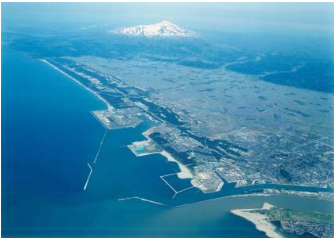
酒田港全景 (平成17年5月17日撮影)
