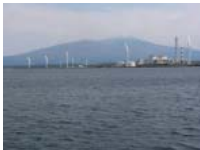
洋上に設置された風力発電
