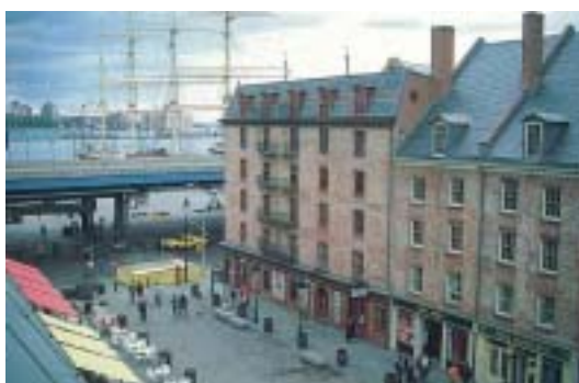
修復利用した建物（写真右）
