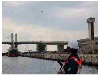
【ドローンによる点検】
