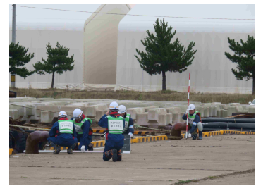
【係留施設点検】
