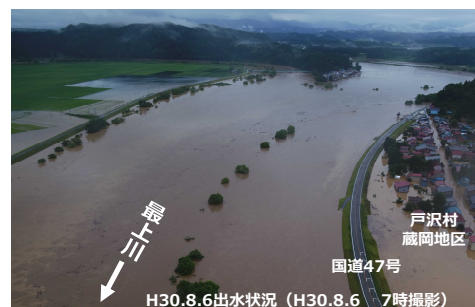
平成30年8月洪水時の状況
