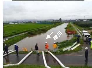
平成26年7月洪水時の状況
