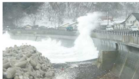
▲国道7号の越波状況
