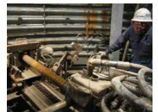
集水ボ-リング 施工状況
