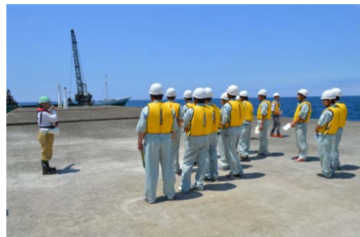
基礎石の投入作業の見学
