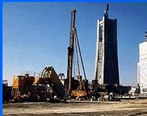
RSW(SMW)工法 (柱列式)
