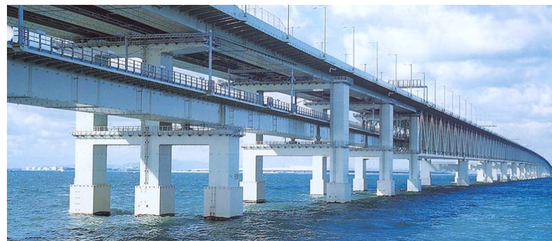
関西空港連絡橋飛沫干満部の防食
