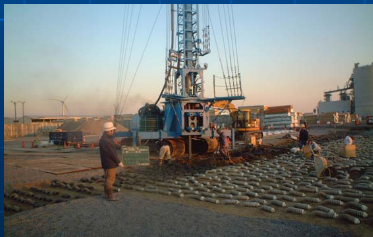
スパイラルドレン施工状況
