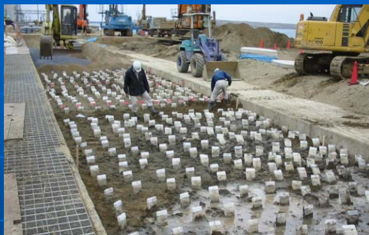
グリッドドレン施工状況
