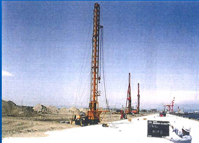
スパイラルドレーン施工状況(a)
