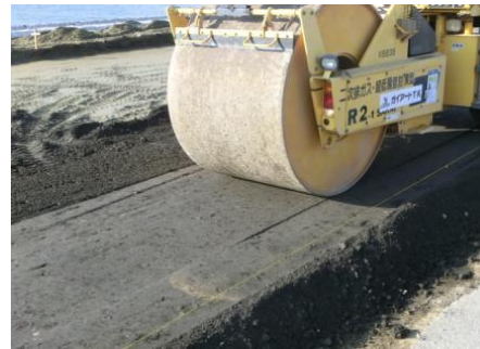
ローラー転圧状況
