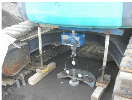
現場CBR試験状況
