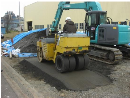
ローラー転圧状況
