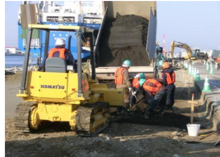
改質土運搬状況
