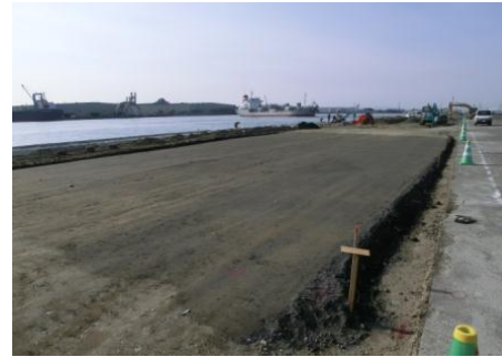
路床完成状況
