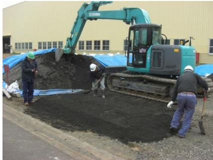
盛土作成状況
