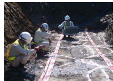
写真-2 造成された改良体
