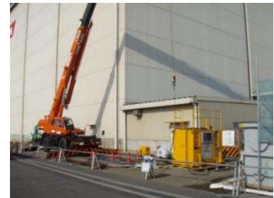
写真-1 施工状況
