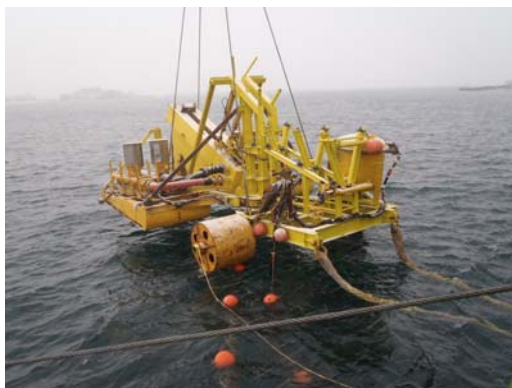
ケーブル敷設
