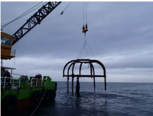
旧波高計用架台撤去
