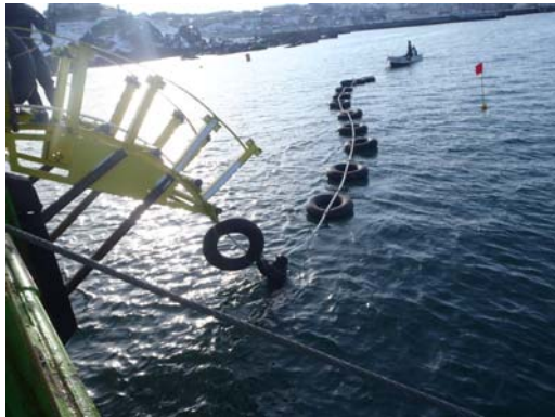
ケーブル敷設
