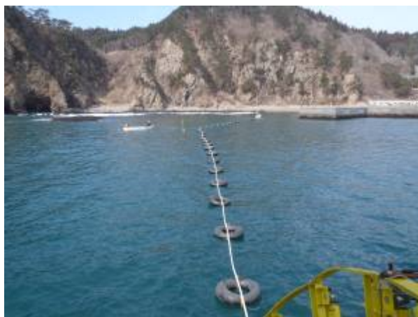
新ケーブル敷設状況
