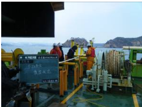
新ケーブル敷設状況
