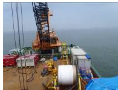
海上ケーブル敷設状況（船上）
