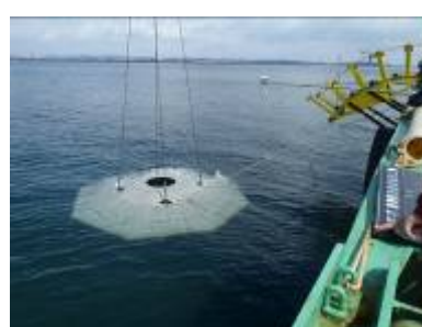
海象計架台設置状況
