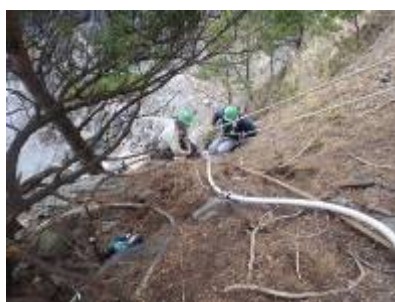
陸上ケーブル敷設状況
