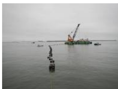
海上ケーブル敷設状況
