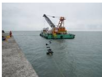
海上ケーブル敷設状況
