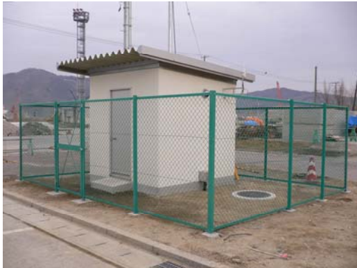
観測施設復旧（地中部マンホール内）
