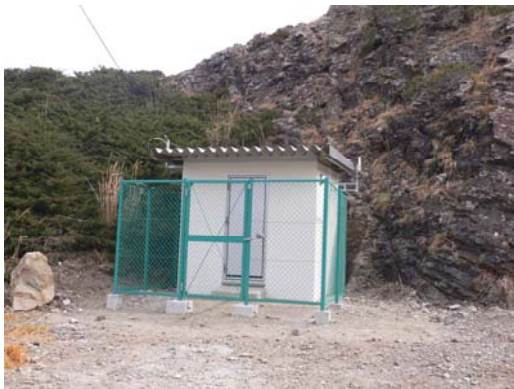
観測施設復旧（新設）
