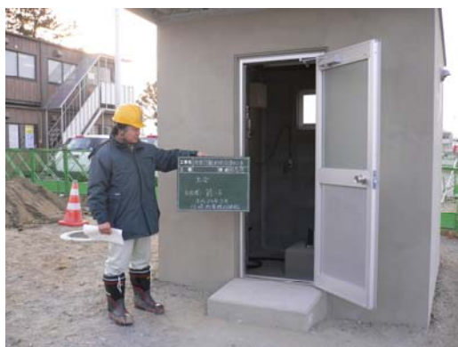
観測施設復旧（新設）
