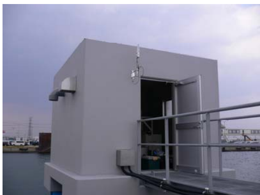
観測施設復旧（新設）
