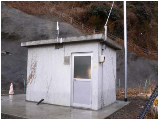
観測施設復旧（既設）
