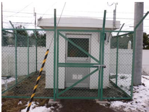
観測施設復旧（既設）
