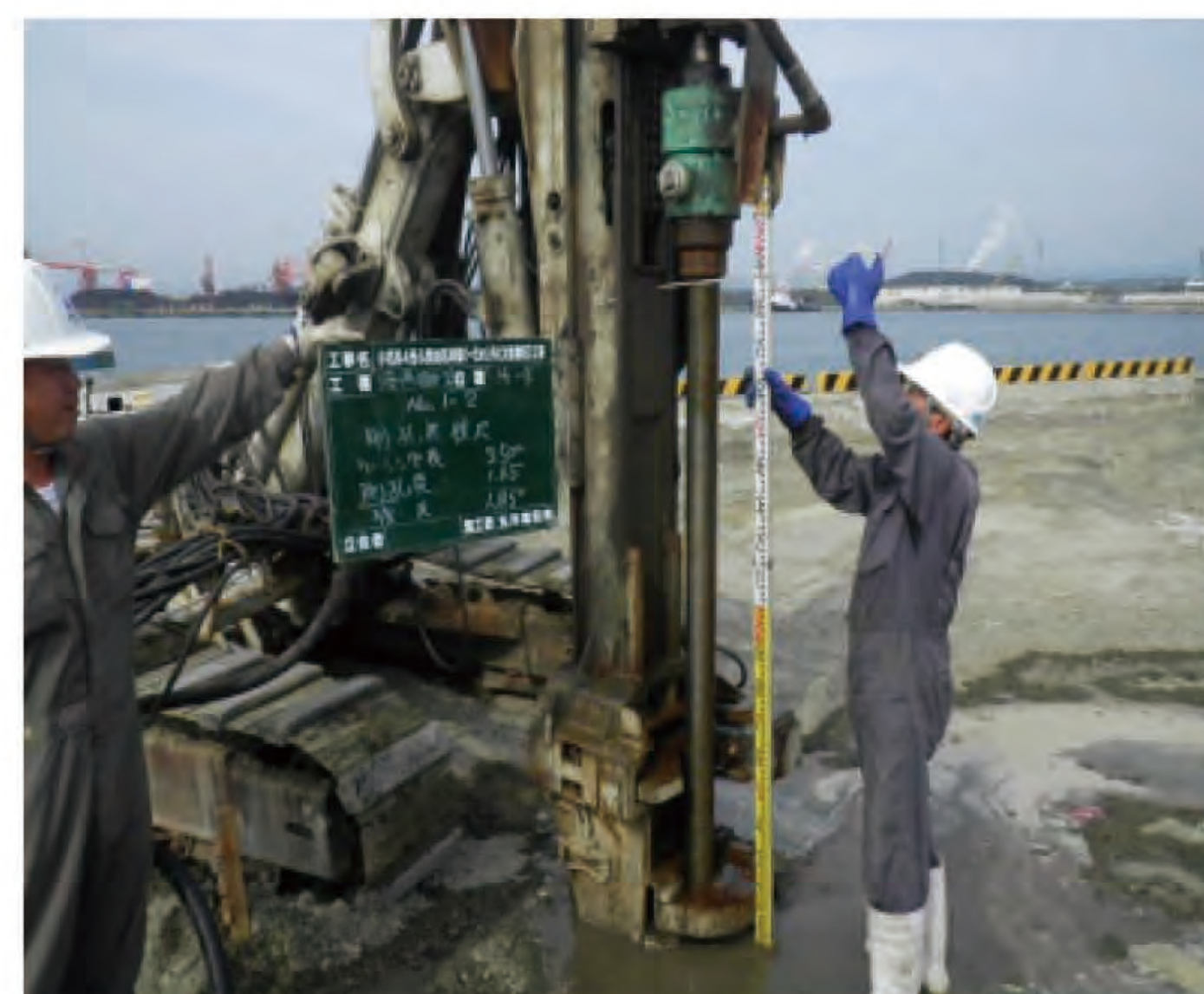
施工状況（4号小頭）
