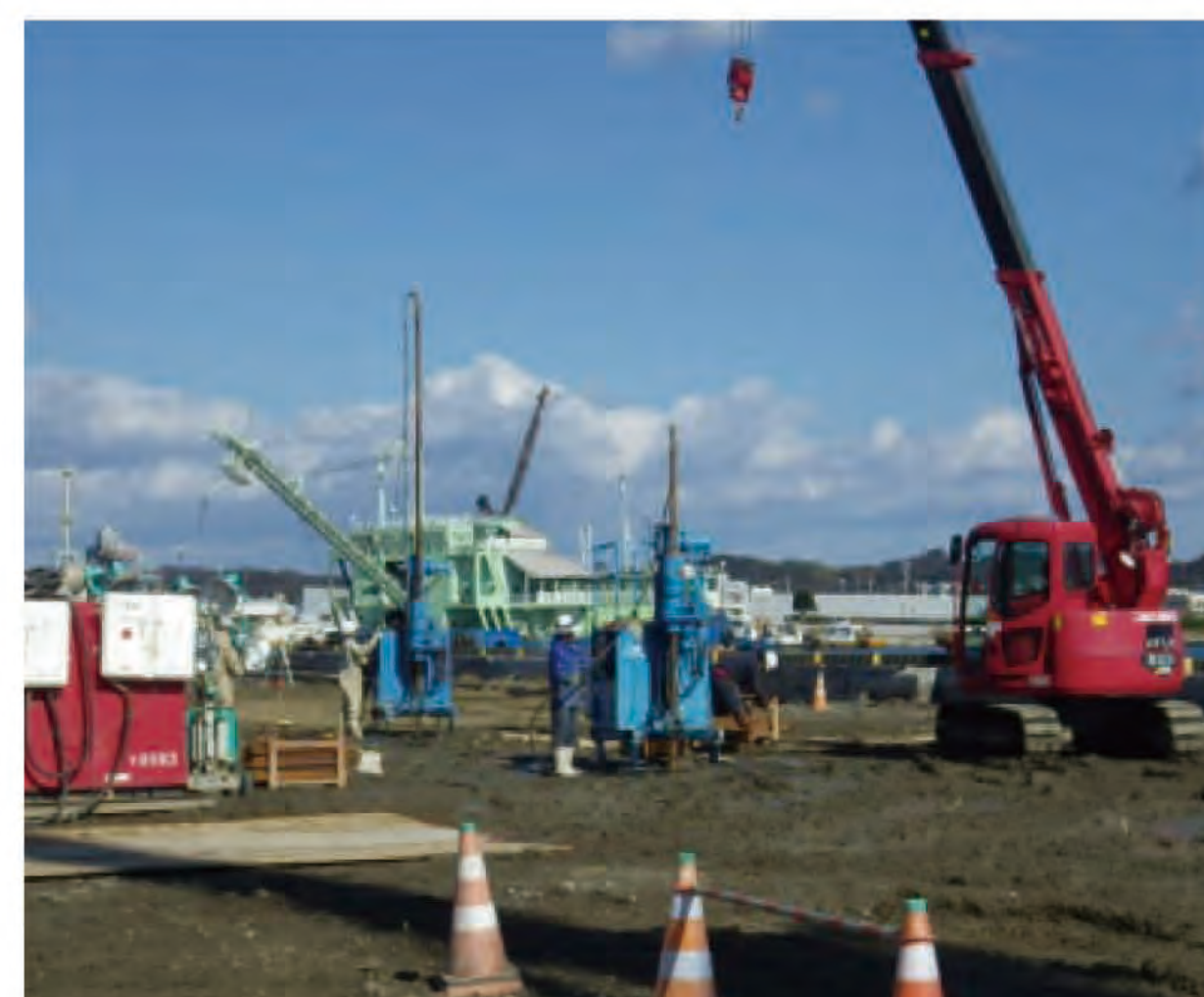
施工状況（3号小頭）
