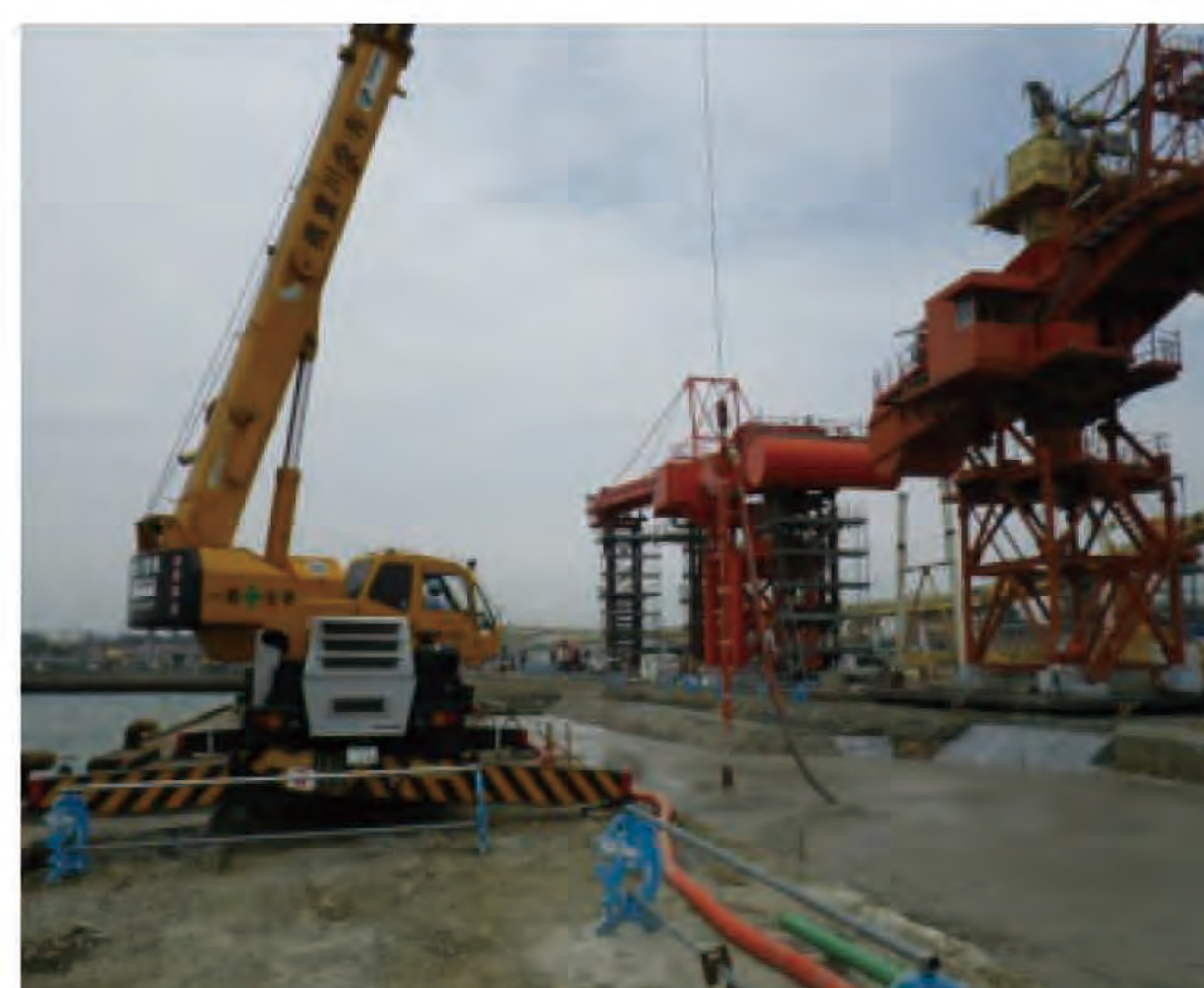
施工状況（7号ふ頭）
