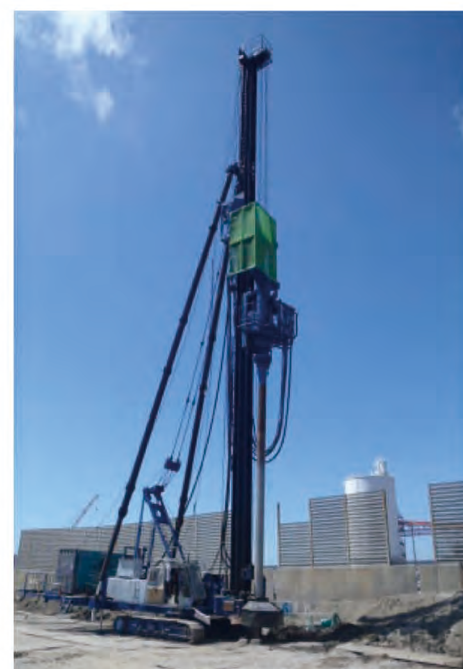
施工状況（7号小頭）
