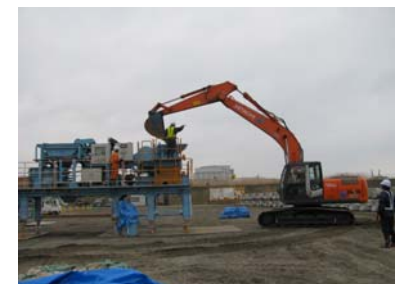
コンクリート廃材投入
