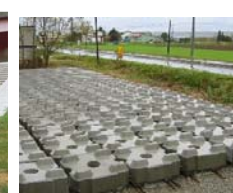
根固めブロック
