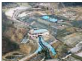
全景 平成16年12月状況
