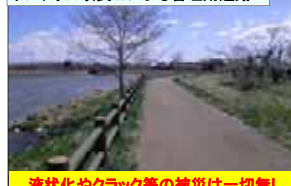
ポンテラン改良土による管理用道路
