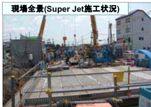
現場全景(Super Jet施工状況)
