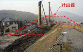
現場全景(着工前)
