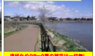
ポンテラン改良土による管理用道路
