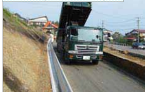
再生改良土(ポンテラン改良土)搬入
