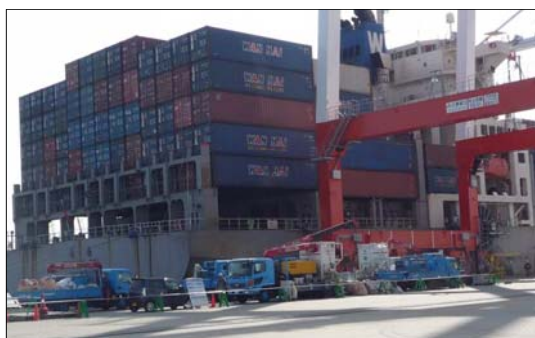
横浜港棧橋 床版補修
