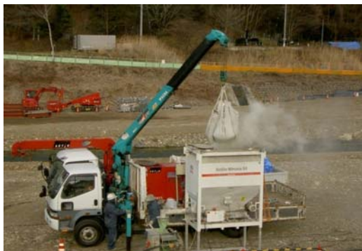
乾式吹付モルタル 投入
