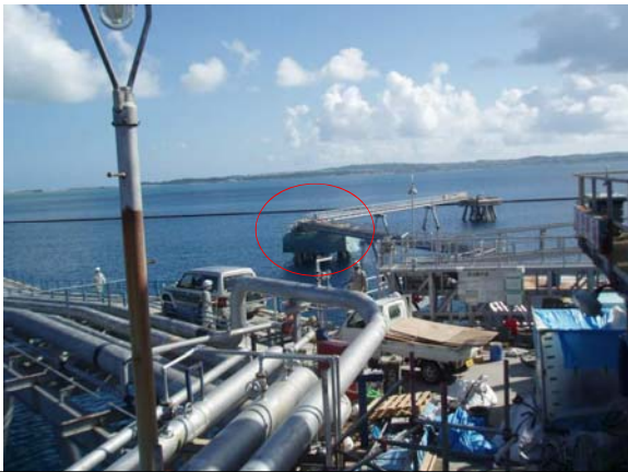
搬送距離 水平 300m で 施工可能
