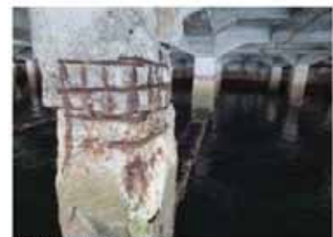
棧橋脚柱部鉄筋露出
