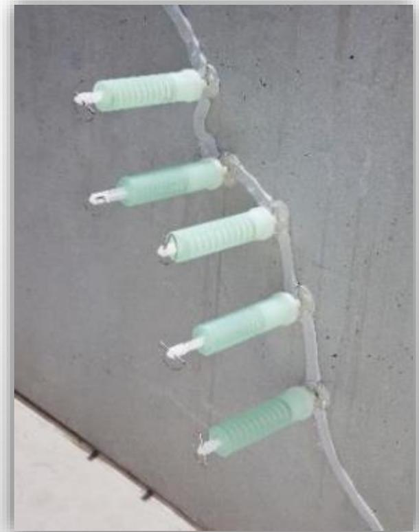
構造体の内部から注入をスタートさせ、低圧力により微細部まで接合させる注入工法
