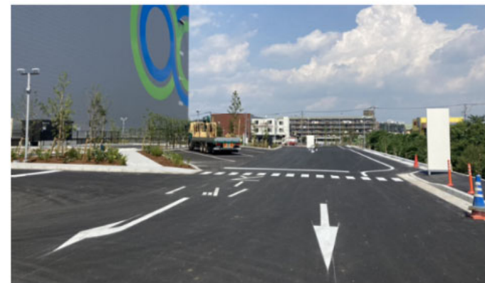
物流センター内舗装
