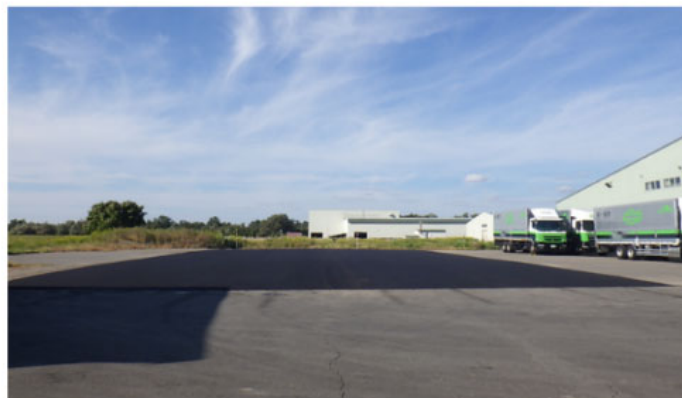
物流センター内舗装
