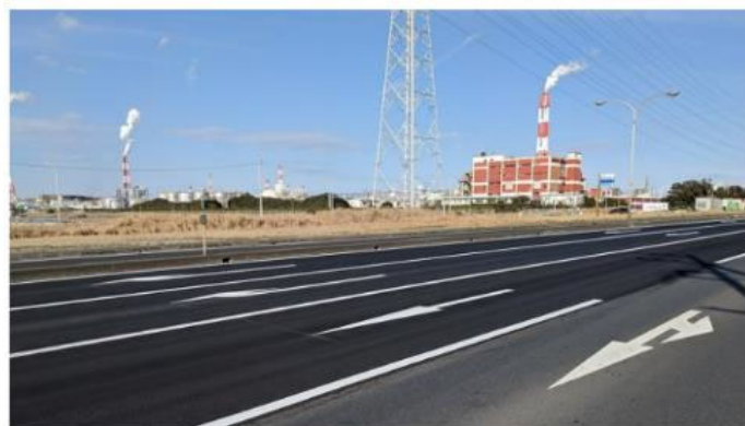
施工半年経過後
