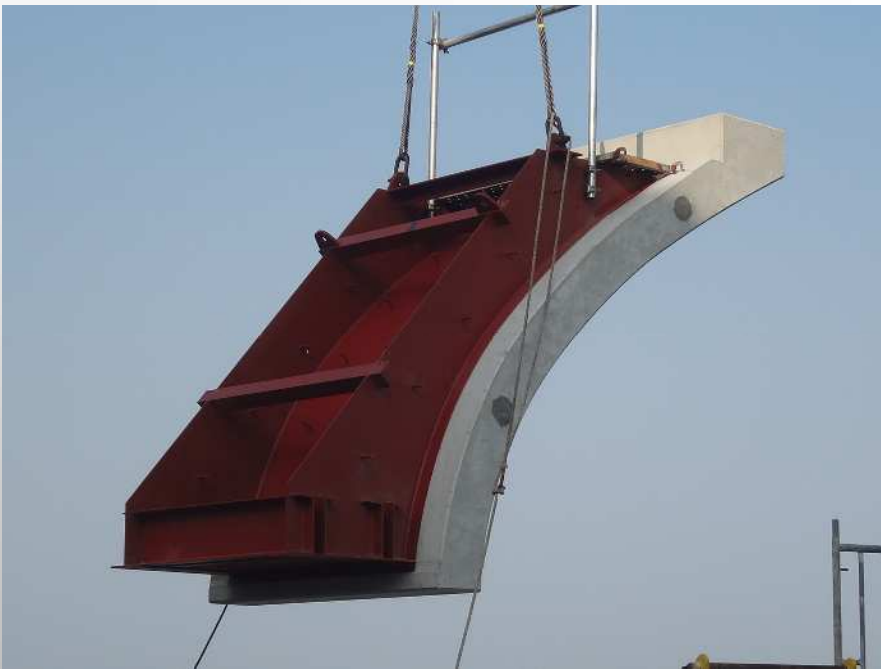
2点吊りで据付開始
