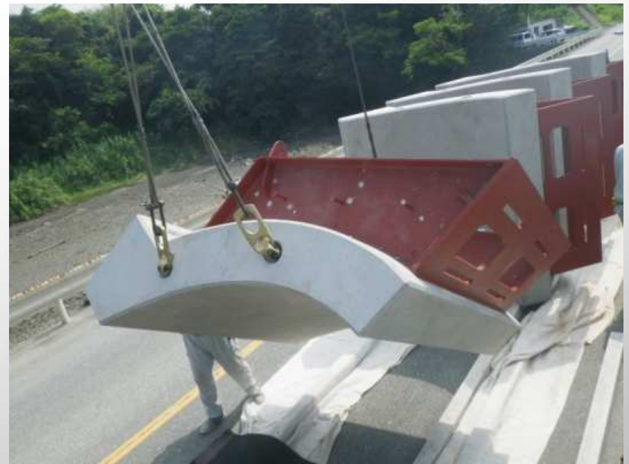
ブロック仮置き（荷下ろし）
