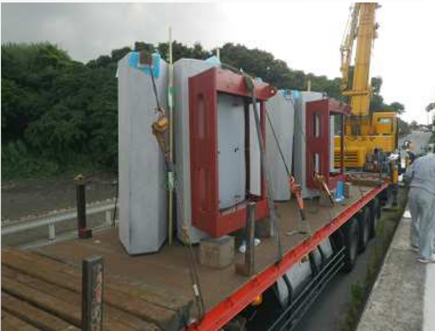
上部フレアブロック搬入
