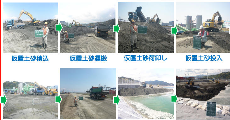
仮置土砂積込 仮置土砂運搬 仮置土砂荷卸し 仮置土砂投入 事前混合処理土製造 処理土運搬 処理土投入 処理土埋立
