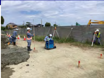
変位測定状況
