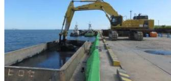
夢前岸壁に土運船を接岸し、浚渫土を均質となるようにバックホウで30分間解泥する。
