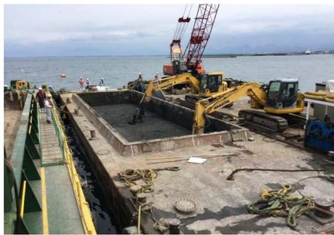
バックホウ混合の施工状況 (海上混合)
