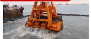
床掘はB-1護岸のSCP盛上り土をクラブ浚渫船 (30m級) で行う。水分を切りながら、水深-18.5mまで掘削し、1,500m<sup>3</sup>積級土運船に積込む。
