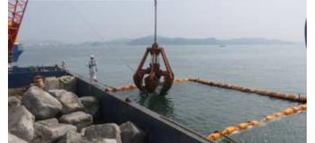
カルシア改質土による基盤が完成した後に、被覆石材(人工石)および覆砂材を投入する。
