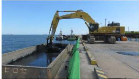
バックホウ混合の施工状況 (岸壁混合)
