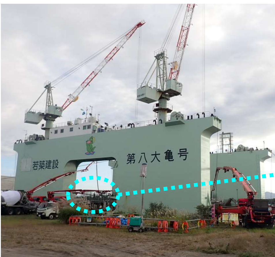
FDによるコンクリート打設の全景
