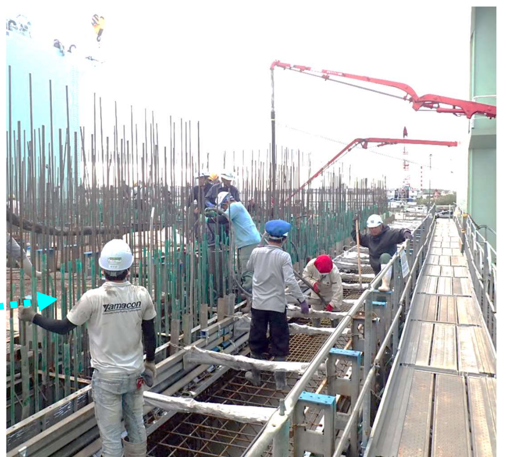
函上の打設状況
