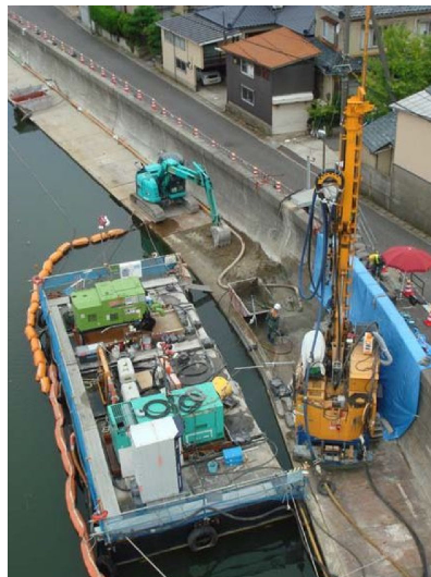
河川堤防での地盤改良（CI-CMC工法）
