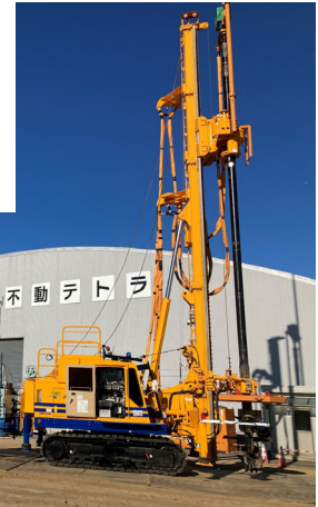
現場検証会の様子（2024年12月）
