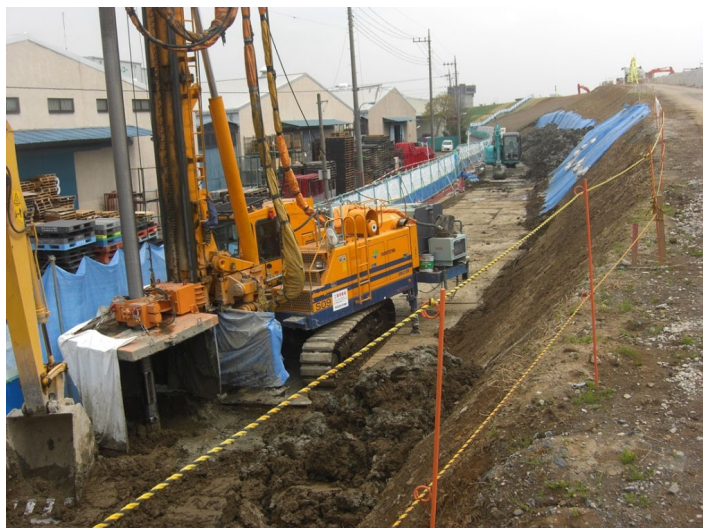
河川堤防での地盤改良（CI-CMC工法）
