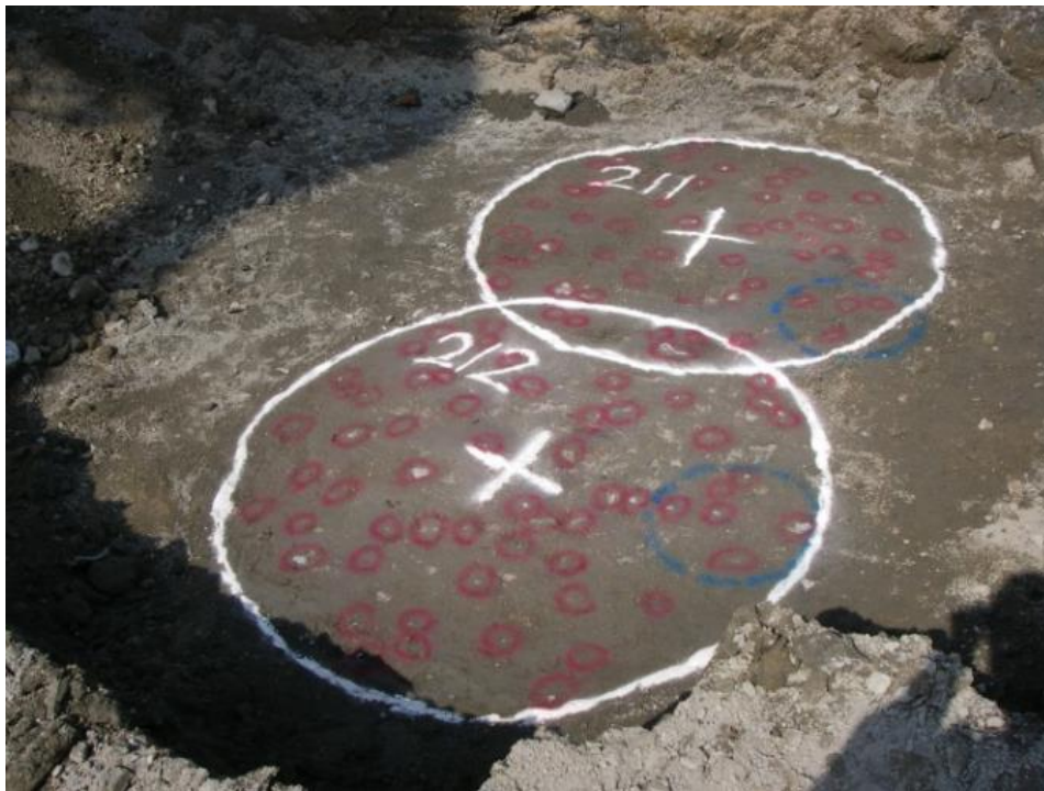
既製杭破砕出来形状況
