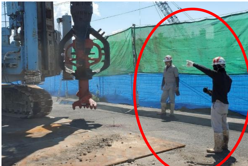
作業人員による誘導
