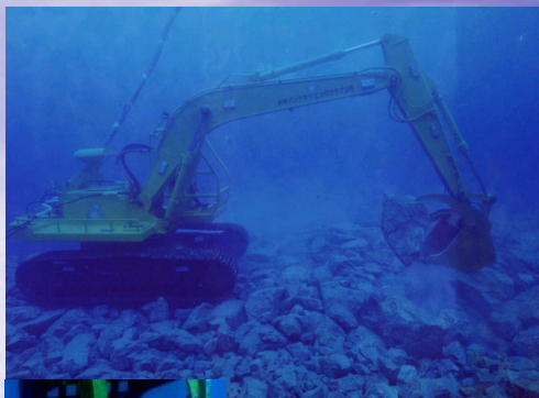
根固めブロック据付・撤去 Installation and removal of base compaction blocks
