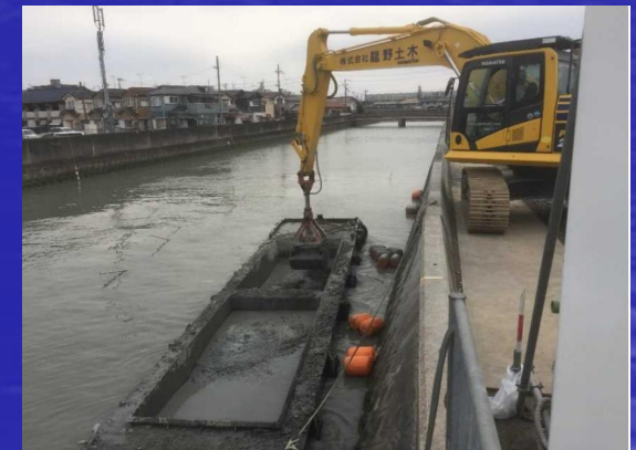
掘削土砂揚土作業
