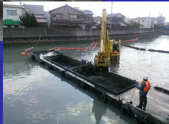
河川内河床掘削積込み作業
