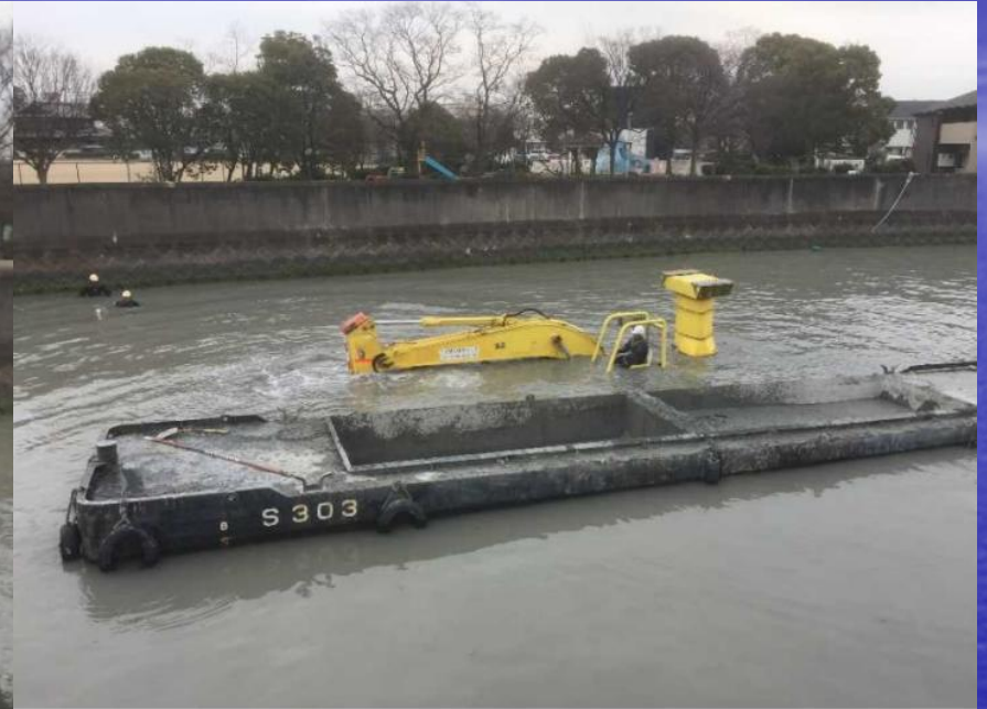
河床掘削積込み作業
