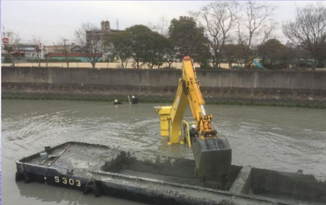
河床掘削積込み作業
