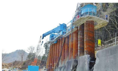
既存防潮堤を撤去せず施工
