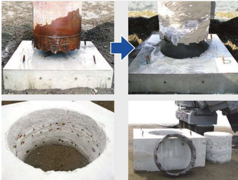
鉄筋コンクリートを回転切削圧入で貫通した実証例
