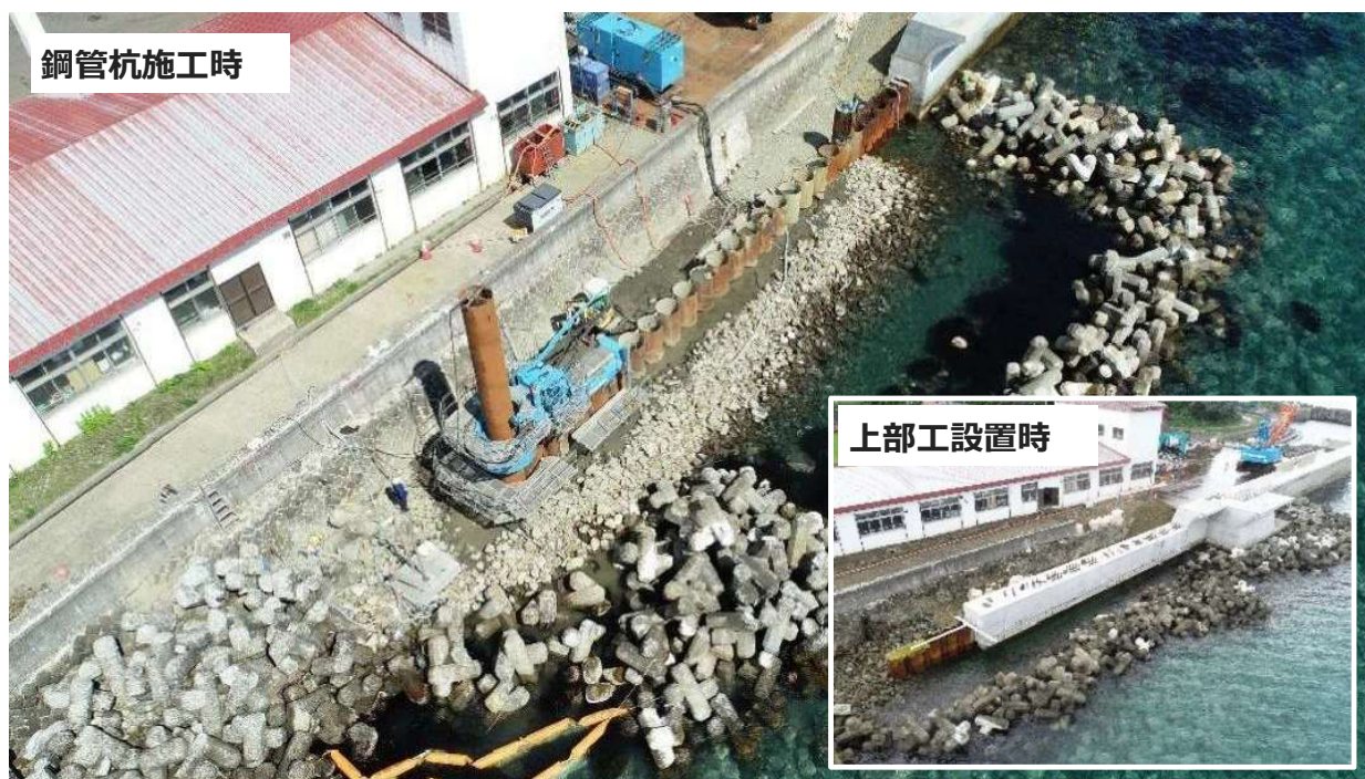
鋼管杭施工時と上部工設置時（右下）
