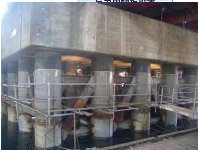
反力用鋼板設置
