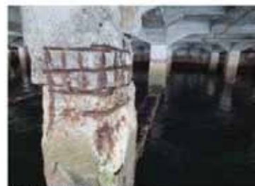
棧橋脚柱部鉄筋露出
