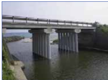
国道9号逢浜橋橋梁補修工事 国交省中国地整松江国道(事): (H22.9~H24.6)
