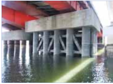
一般国道357号辰巳橋(山側)耐震補強工事 国交省関東地整川崎国道(事):(H19.1~H20.3)
