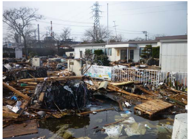
石巻港出張所の状況(3月13日)
