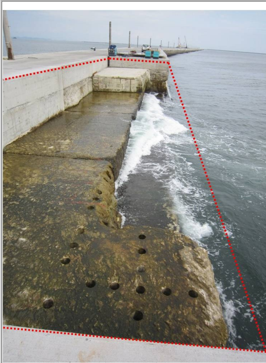
コンクリート打設前の状況【南防波堤】
