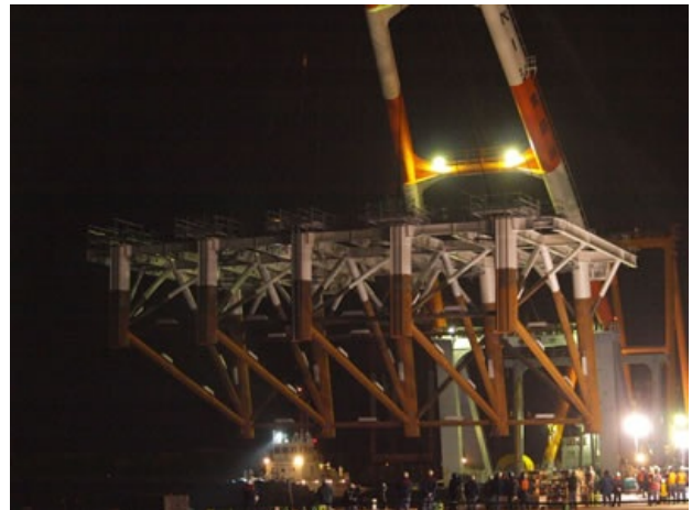
起重機船による据付作業
