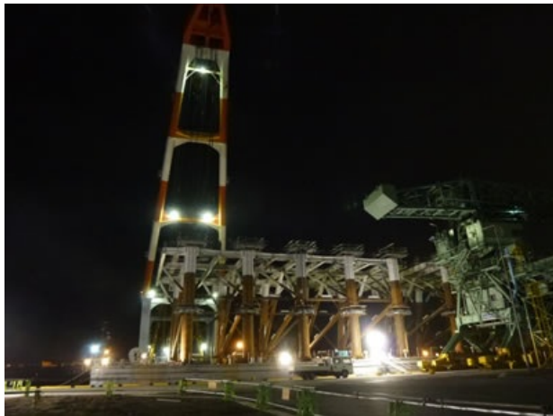
吊り上げを待つ岸壁本体(ジャケット)
