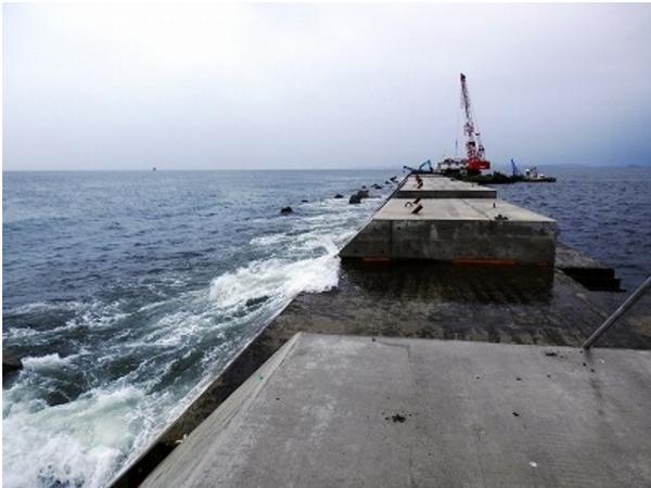
写真③: 荒天時に高波が沈下した防波堤を
